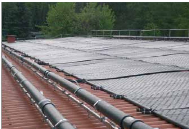
Plat dak montage
