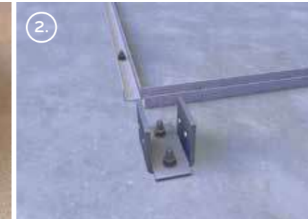
2. U-profielen bevestigen op betonplateau
