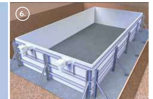
6. Liner en inbouwelementen installeren (skimmer, terugvoer,...)
