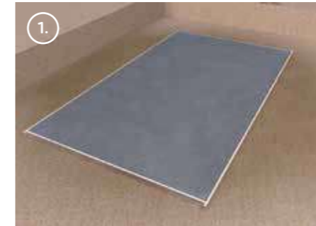
1. Betonplateau 15 cm gieten met wapeningsnet 8/8/150/150
