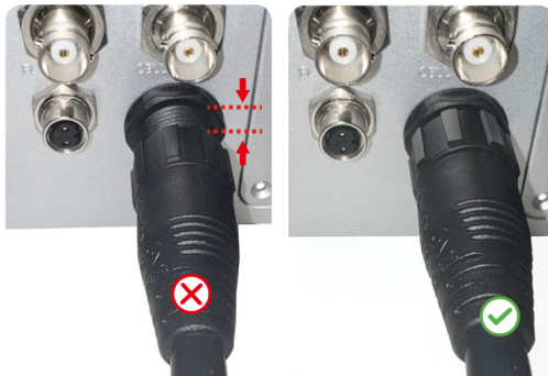
Figuur 5. Installatie celkabel
