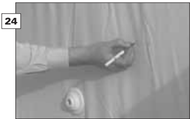
Teken de opening van de skimmer af op de folie.
