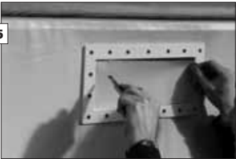
Bevestig de tweede dichtingsring van de skimmer op de liner. Zorg er voor dat de schroefgaten in de afdichtingsring overeenkomen met deze van de skimmer. Schroef nu de afwerkingskap erop (bijhorende vijzen in doos van skimmer). Snij nu het stuk liner uit in de skimmermond. Klik daarna de afdekplaat erop. Nu dient u de koppeling te plaatsen en te verbinden met de kraan via een slang (zie techn gedeelte: 2.4.3 Aansluitingen) zodat het bad verder kan gevuld worden.
