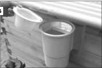
Plaats het mandje in de skimmer (2x) en sluit de skimmer af met het deksel. Het zwembad is nu volledig klaar behalve het technische gedeelte van de filterinstallatie.
