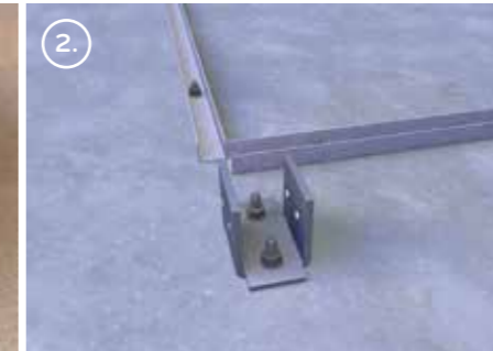
2. U-profielen bevestigen op betonplateau
