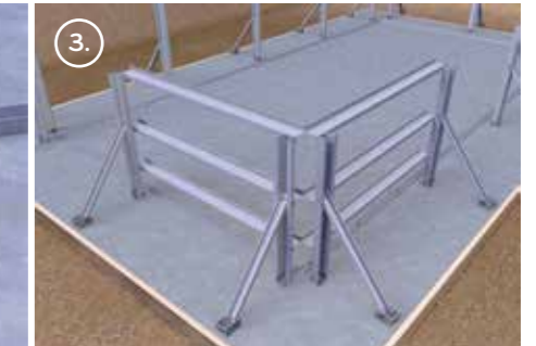
3. Opbouw van de metalen structuur
