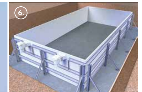
6. Liner en inbouwelementen installeren (skimmer, terugvoer,...)
